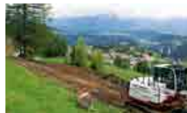
Ausbau in Schönberg Richtung Wipptal
